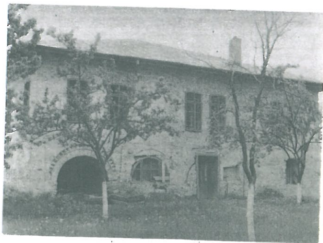
Fig. 7. Fațada de nord, după decaparea tencuielilor.
