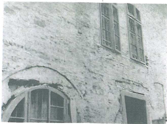
Fig. 14. Fațada de nord. Detaliu de zidărie.
