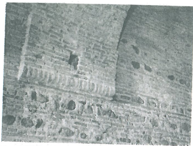
Fig. 5. Zidăria pivniței și arc-dublou.
