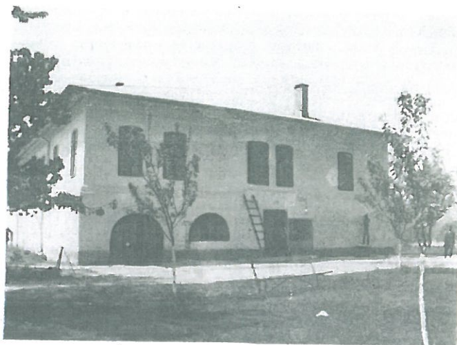
Fig. 13. Fațada de nord, înainte de începerea cercetărilor.
